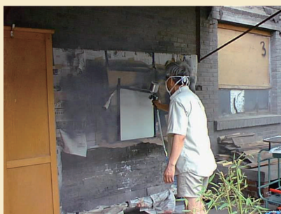
图2 1999年6月，在技物楼后平房喷涂石墨电极层
